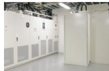
無停電電源装置 (UPS)
