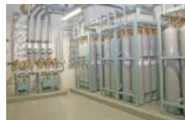
消火ポンペ室
