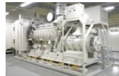
非常用発電機
