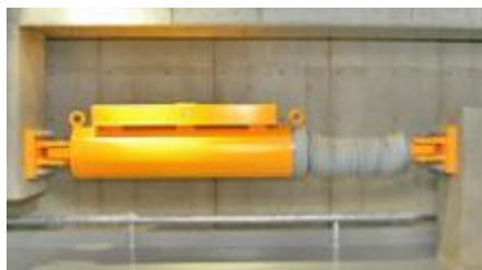
オイルダンパー(制震装置)
